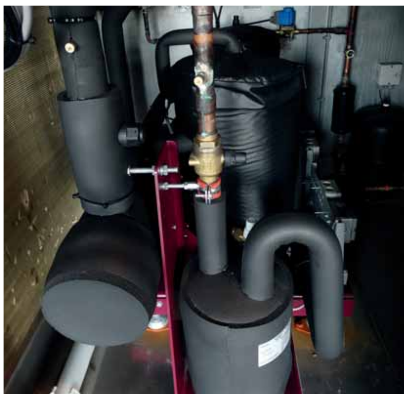
De nieuwe situatie: een modulerend warmtepompsysteem.
