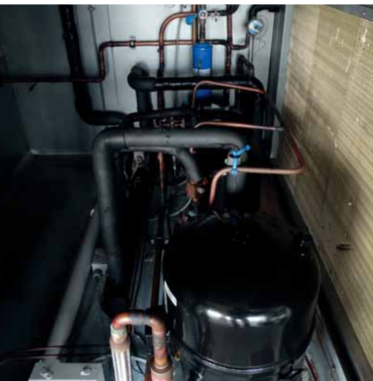
De oude situatie, met drie 'aan/uit'-compressoren op een rij.
